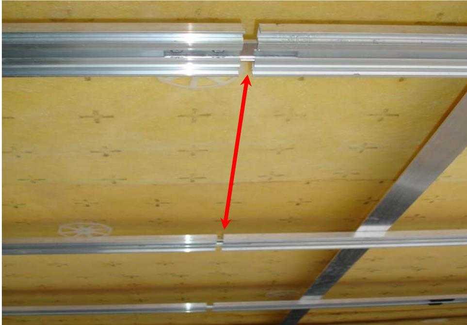
7. Bei Leibungen ist der **max. Profilüberstand** des <<WTP 05>> Profils **250 mm (Auskrümmung)**.
