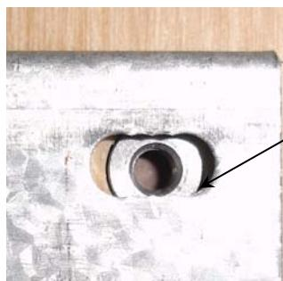
Le profil <<small T>> avant le vissage avec l'ancrage de plaque.
