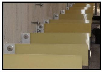
tuellen Wärmebrücken Unterkonstruktionskonsolen einen immer massgebenderen Faktor auf den U-Wert Konstruktion dar. Bei solchen Wandkonstruktionen beträgt der Einfluss der Konsolen mitunter 15-30%. Insbesondere bei der Sanierung von Gebäuden resultieren daraus unverhältnismässig hohe Dämmstärken, welche den Wohnkomfort durch Beschränkung des Tageslichteinfalls im Bereich der Fensterleibungen mindern. Zudem können bei Balkonen diese Dämmstärken nicht aufgebracht werden,
