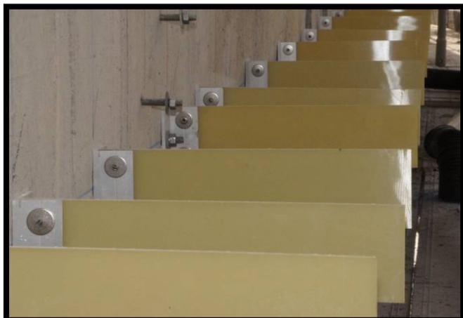
da sonst die Nutzung der Balkone zu stark gemindert wird. Mit diesen Kenntnissen hat die Wagner System AG eine neue energieeffiziente Fassadenunterkonstruktion <<WDK>> Phoenix entwickelt. Diese erfüllt nun die Anforderungen der Aussenwandbauteile und erhöht somit die Qualität der Wärmedämmungen.
