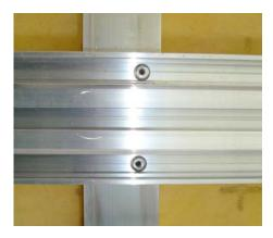
5. Nach Möglichkeit sollte die Profilverbindung nicht in der Mitte der beiden vertikalen Tragprofile liegen. Der ideale Verbindungspunkt (VP) ist vertikaler Profilabstand (SA) \* 0.2 (900 mm\*0.2= 180 mm(VP))
