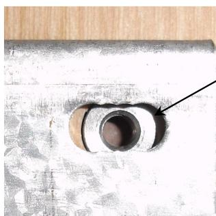
Das **small T** Profil vor der Verschraubung mit dem Plattenanker.
