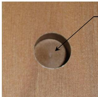
Bohrung für Plattenanker.
