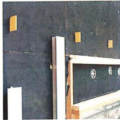
Das wärmebrückenfreie System «Phoenix-Facade» aus hochfestem, glasfaserverstärktem Kunststoff kann grosse Lasten aufnehmen
